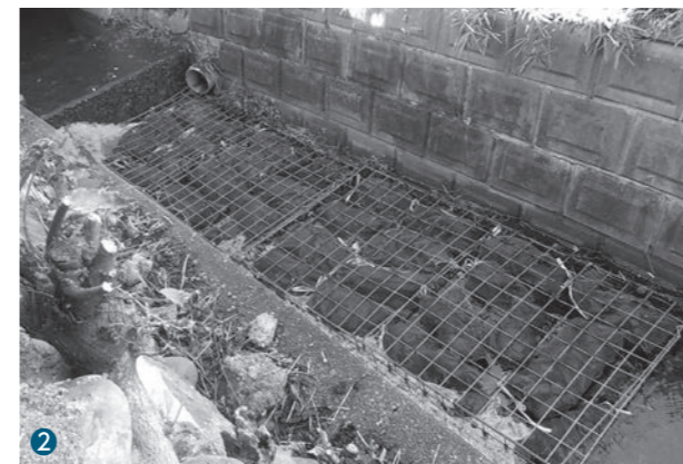
1 木炭入れ替え作業中です。2 作業実施後、木炭が設置されました。3 作業後の参加者全員です。
