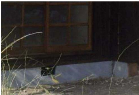
コンクリート基礎等（評点0）
