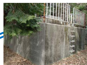
大附配水池 標高=359.5m
