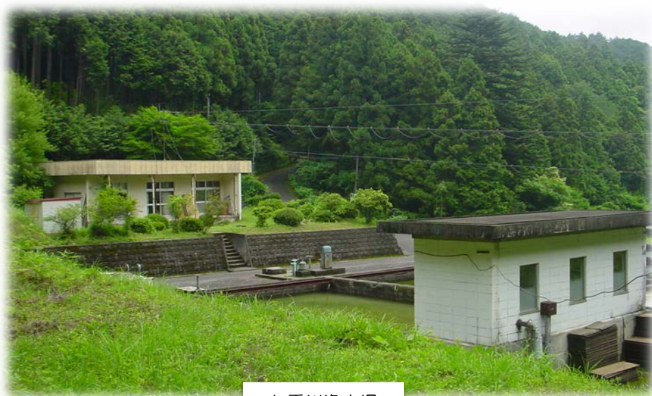
七重川浄水場
