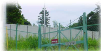
本郷中央配水池
