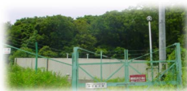
本郷高区配水池
