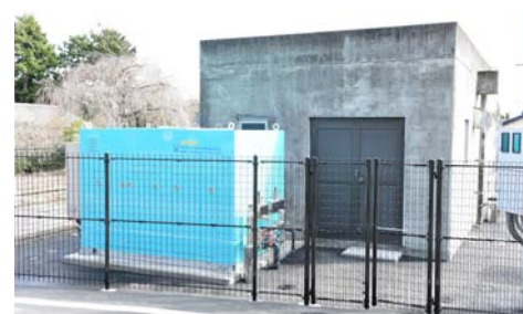
柵平浄水場及び急速ろ過装置
