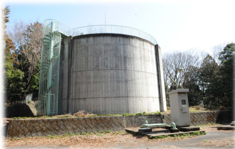
春日山配水池
