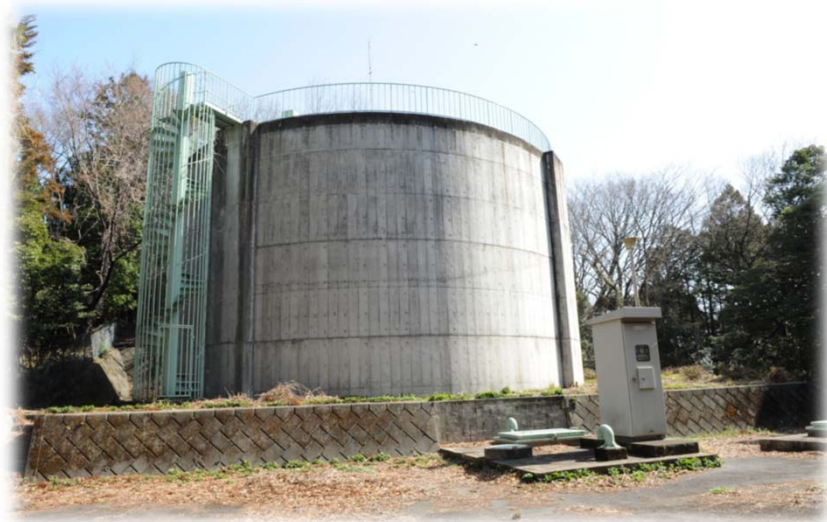
春日山配水池
