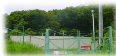
本郷高区配水池
