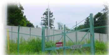
本郷中央配水池
