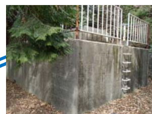
大附配水池 標高=359.5m
