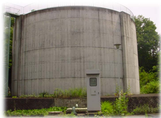
春日山配水池
