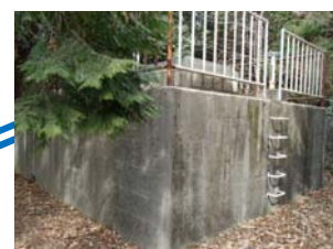
大附配水池 標高=359.5m
