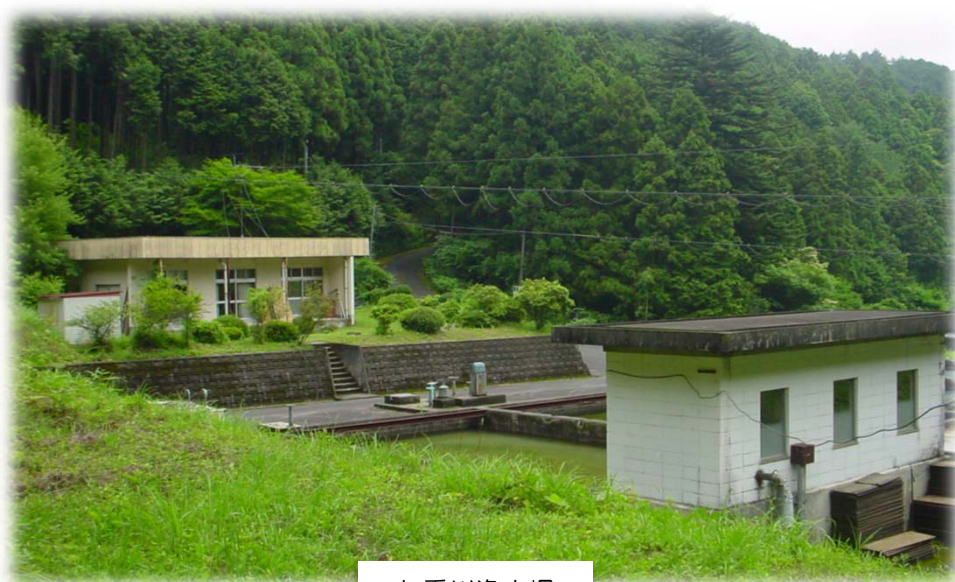
七重川浄水場
