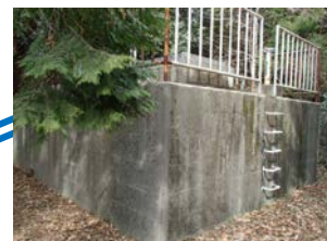
大附配水池 標高=359.5m
