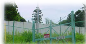
本郷中央配水池
