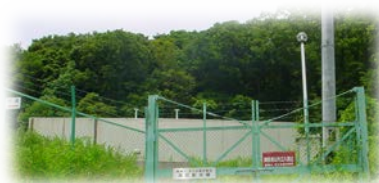
本郷高区配水池
