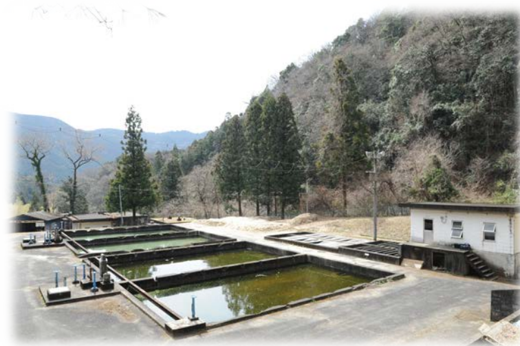
七重川浄水場
