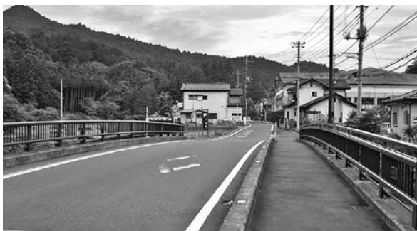
歩道が整備されている町道
