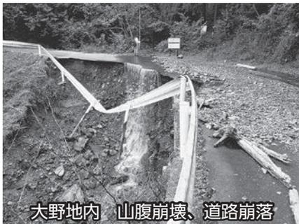
大野地内 山腹崩壊、道路崩落
