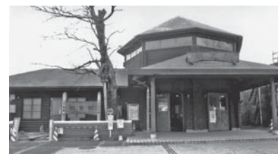
工事中の明覚駅
