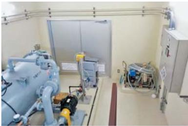
写真右) 緊急時浄水機
