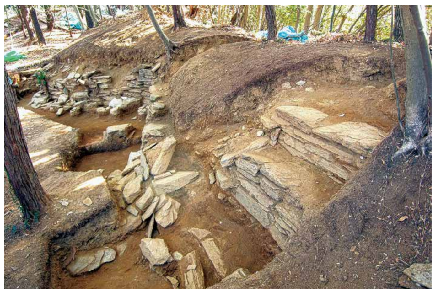
▲ 本郭石積み遺構 (西から)
