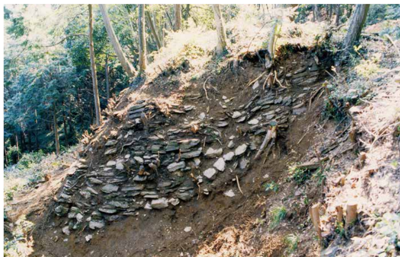
▲ 腰郭石垣北側面 (北より)
