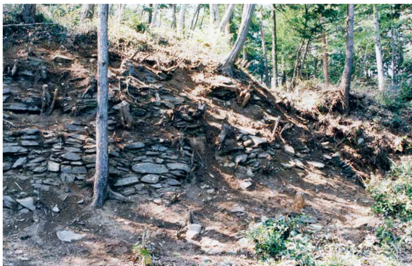
▲ 腰郭石垣正面 (南東より)
