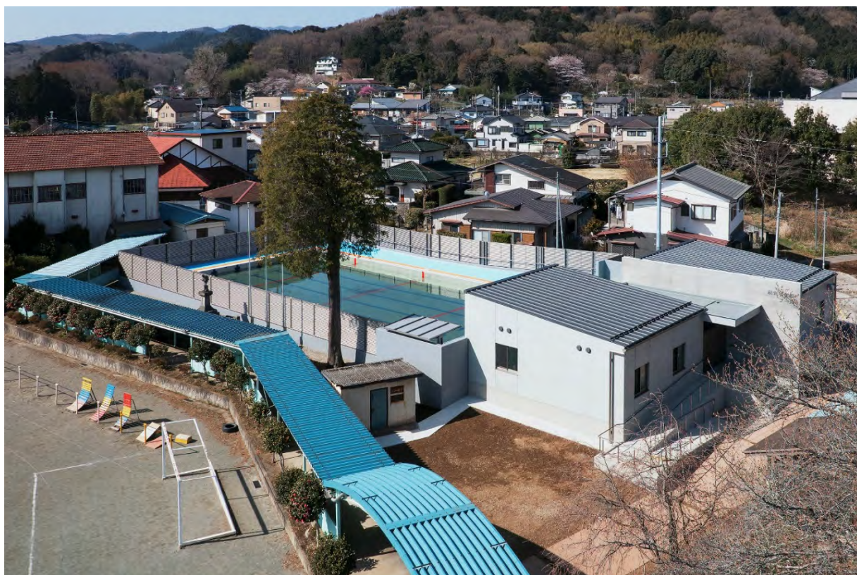
令和2年度改築竣工 明覚小学校プール
